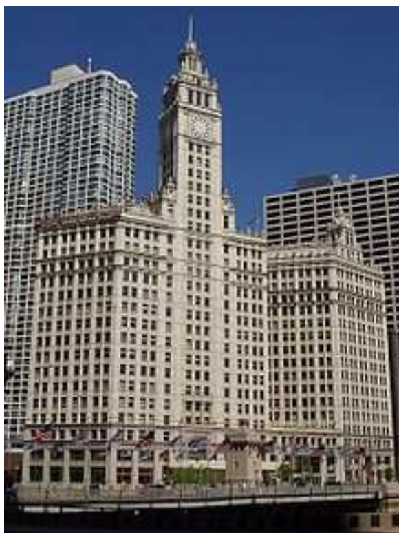
La sede centrale della Wrigley a Chicago
